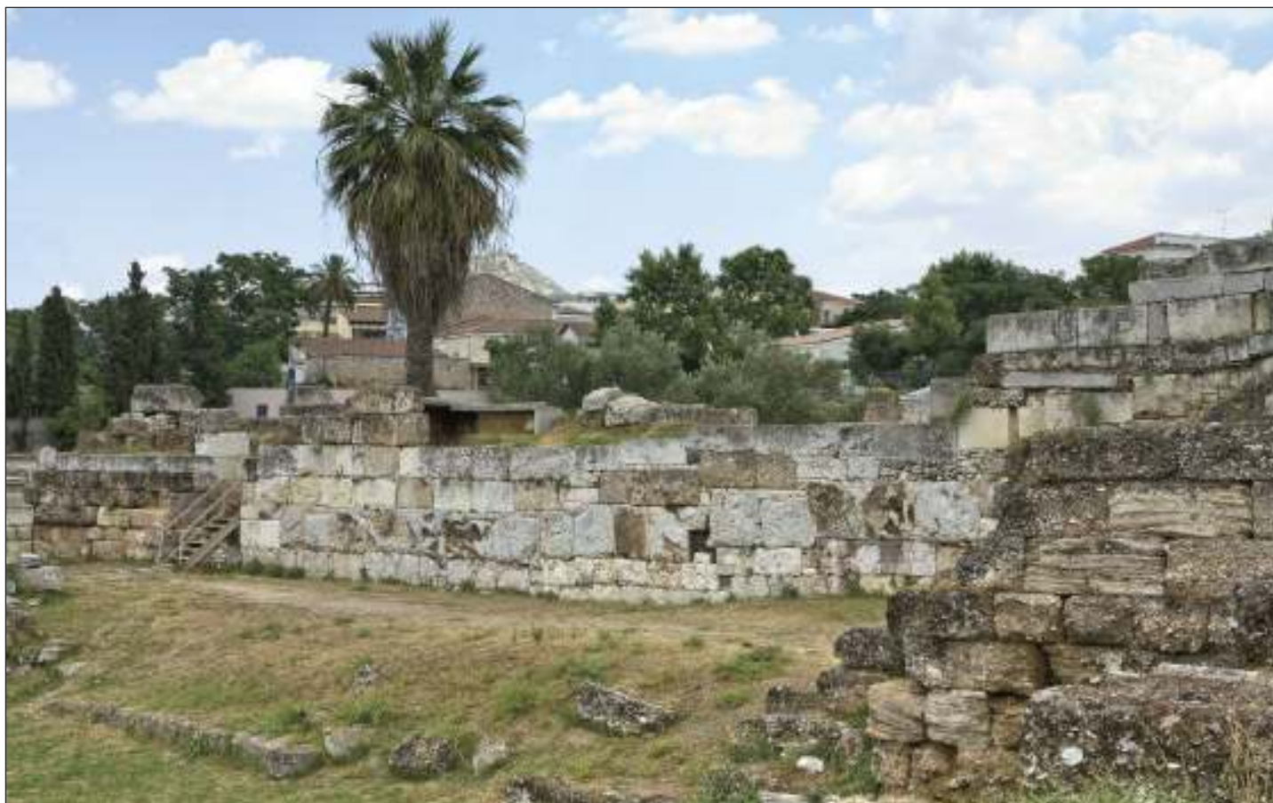
Το μεσοπύργιο νοτίως της Ιεράς Πύλης όπου διακρίνονται καθαρά οι επάλληλες φάσεις επισκευών της οχύρωσης.
