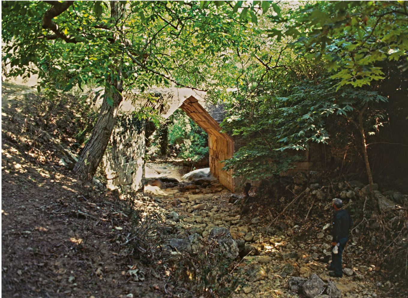
Άποψη της αρχαίας ελληνιστικής γέφυρας της Ελεύθερνας.
