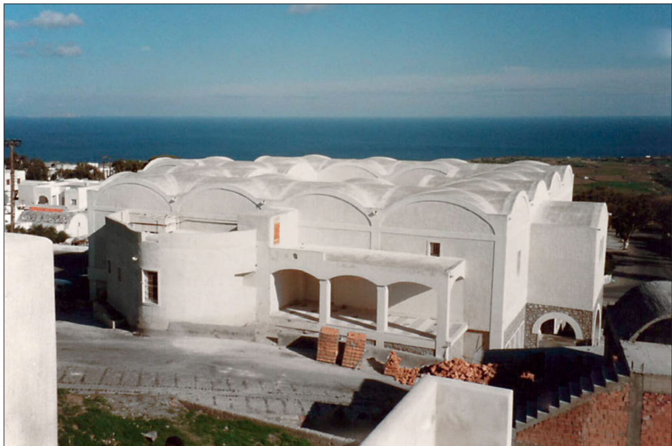
Γενική άποψη του μουσείου από νοτιοδυτικά. Διακρίνονται η στέγη με τα σταυροθόλια, το ανοικτό προστώ και η είσοδος στον δεύτερο όροφο.
