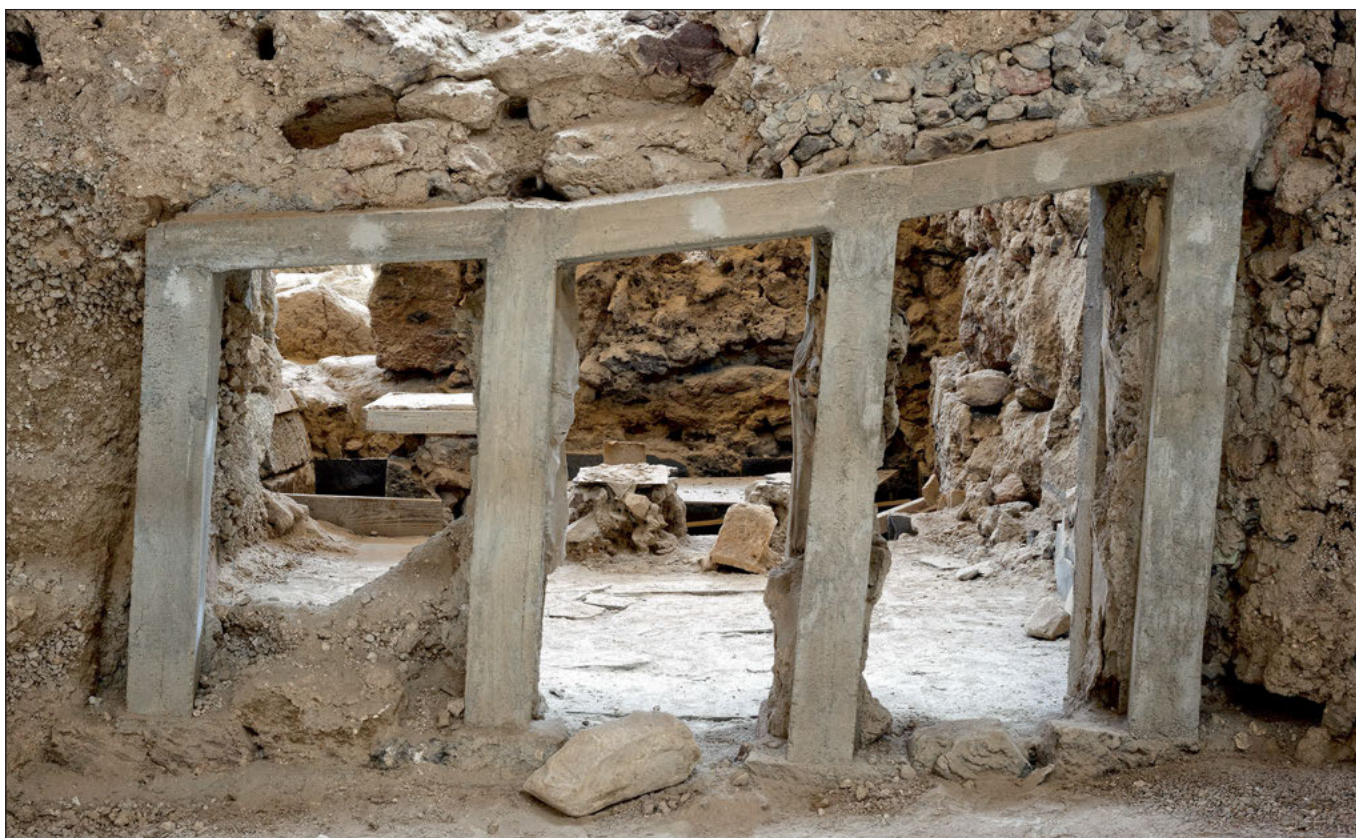
Πολύθυρο στο ισόγειο της ανατολικής πτέρυγας της Ξεστής 3. Το πλαίσió του, στρεβλωμένο μετά την αποσύνθεση του ξύλου, αντικαταστάθηκε με οπλισμένο σκυρόδεμα κατά την διάρκεια της ανασκαφής του.
