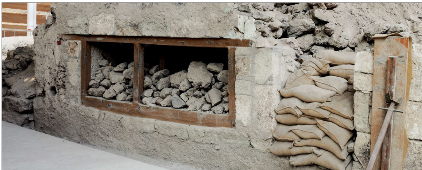
Τμήμα από την πρόσοψη της ανεξερεύνητης ακόμη λεγόμενης Οικίας της Άγκυρας, στην δυτική πλευρά της Πλατείας Τριγώνου. Διακρίνονται τα πλαίσια θύρας και παραθύρων από πελεκητούς τόφφους.
